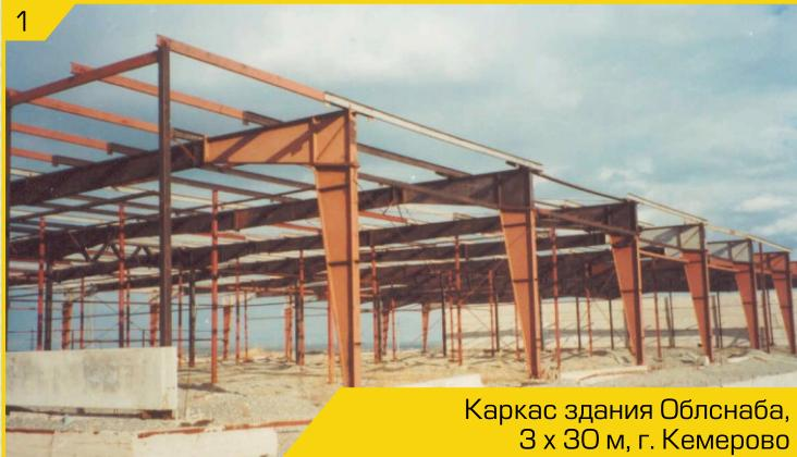
Фирмой УНИКОН были спроектированы и построены более 200 зданий и сооружений общей площадью свыше 1,0 млн. М<sup>2</sup>, в которых использованы рамные конструкции переменного сечения, в т.ч.:
